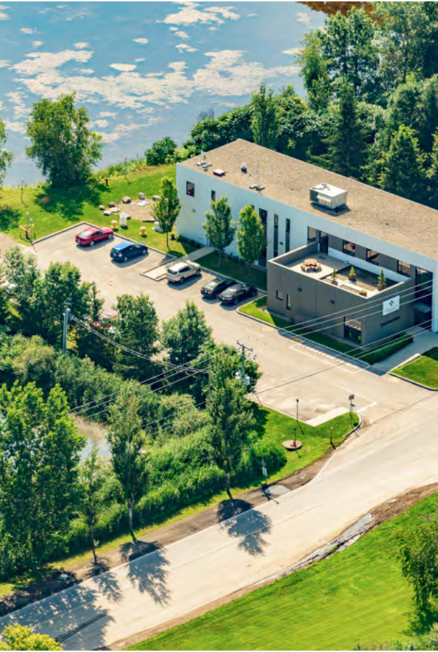
Complexe Enviro Connexions (Terrebonne)
